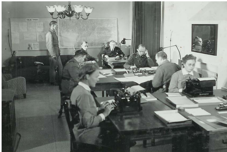
Luftvärnscentralen i Disponentbostaden på Boåsen
